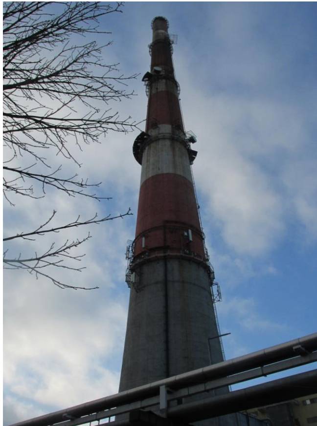
Zał. nr 1: Widok ogólny instalacji radiokomunikacyjnej.
